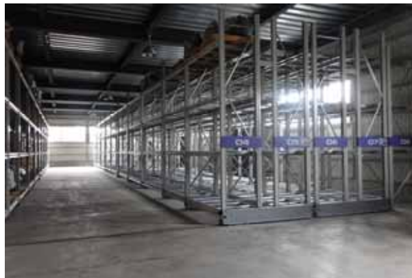
(新設中の簡易移動ラック)
