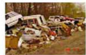
廃棄車両の撤去作業
