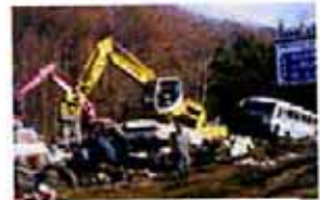
廃棄車両の撤去作業
