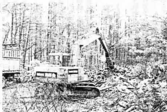
散乱する廃タイヤを撤去
