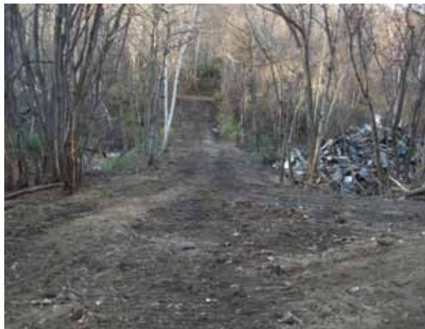
(数ヶ日で廃棄物等を撤去作業が終了)
